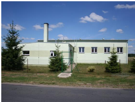
Wiejska Stacja Uzdatniania Wody w Łaszczynie
