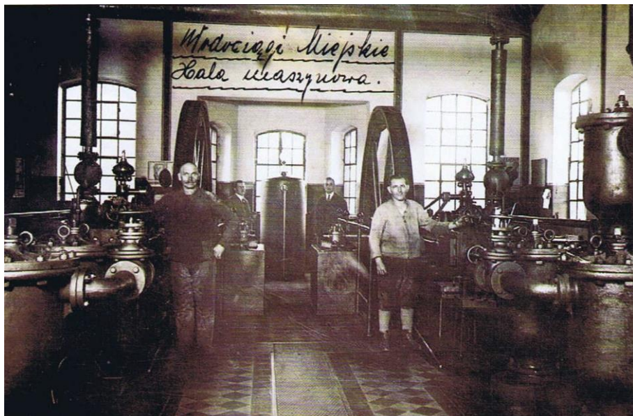
Stacja pomp parowych w Świniarach – hala maszynowa, fot. z okresu międzywojennego
