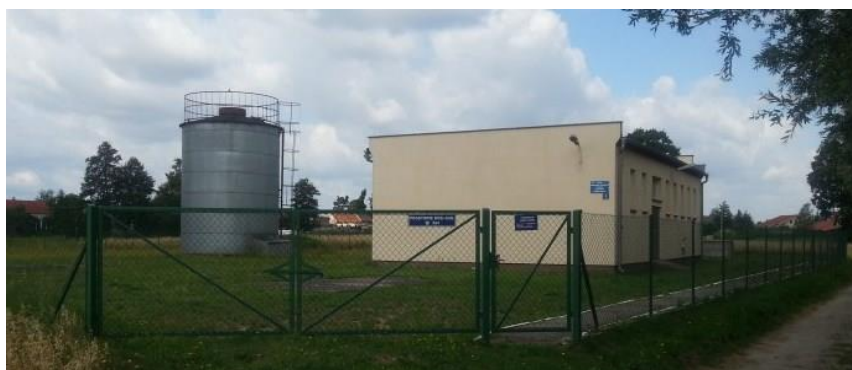
Wiejska Stacja Uzdatniania Wody w Dębnie Polskim
