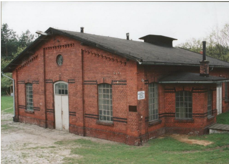
Budynek dawnej Stacji pomp parowych w Świniarach.
