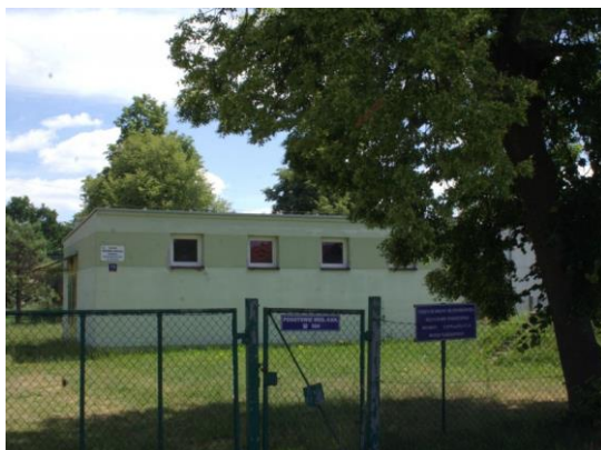
Wiejska Stacja Uzdatniania Wody w Iźbicach
