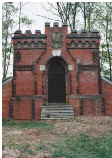
Pierwsza budowla - zapasowy zbiornik wody czystej w Świniarach z 1896r.
