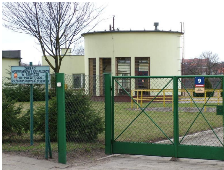
Przepompownia ścieków przy ul. Przyjemskiego
