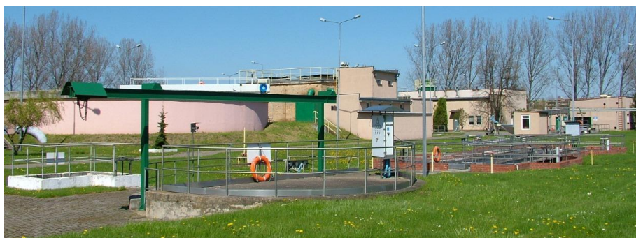
Obiekty Oczyszczalni Ścieków dla miasta Rawicza
